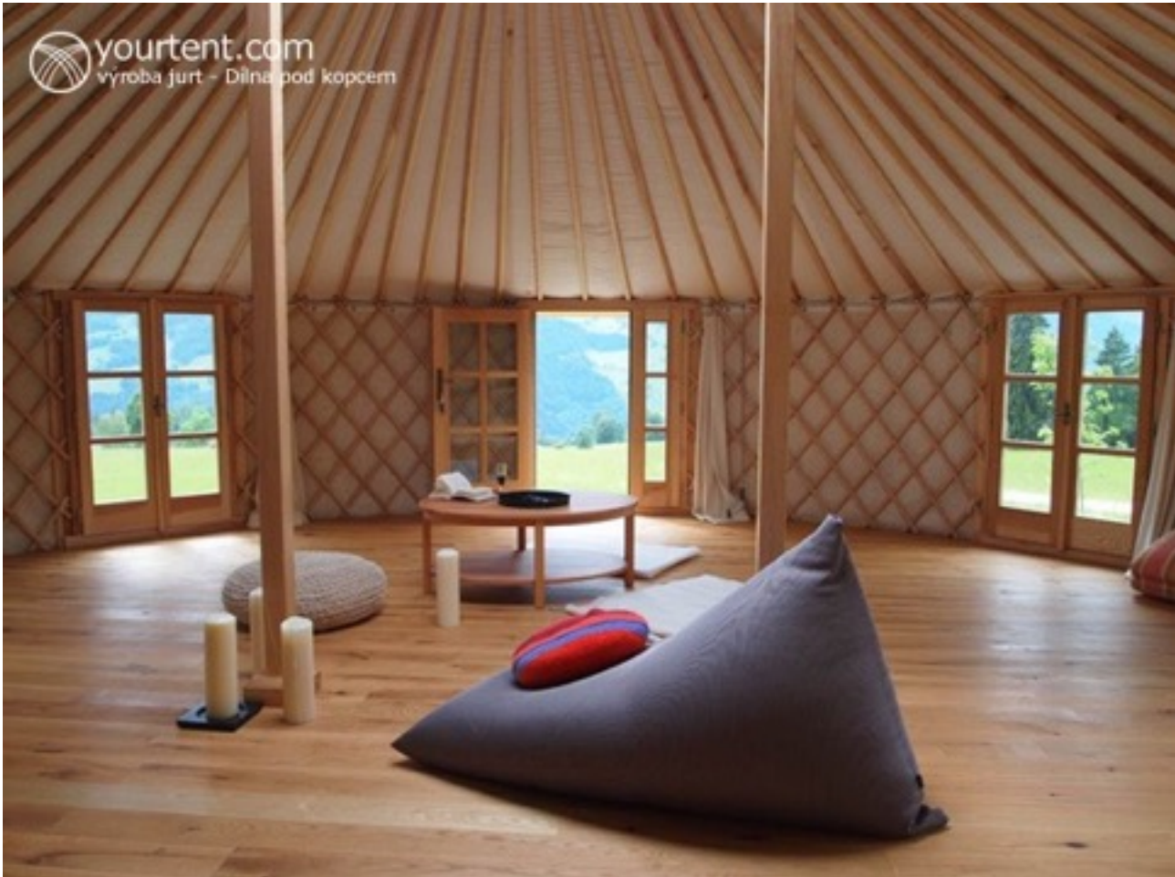
Aufgebaute Jurte. Sprossenfenster aus Lärchenholz. Inklusive Oberlicht mit 180cm Durchmesser (aus doppelschaligem Isoglas inklusive Lüftungsfunktion)
