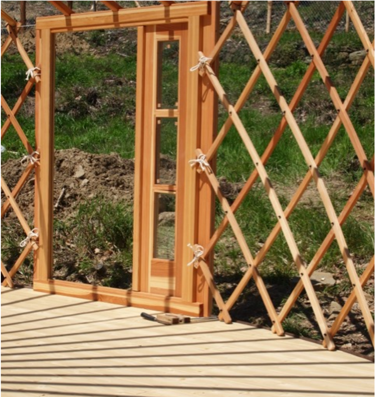
Jurte im Aufbau: Scherengitter und Doppeltüre mit Sprossenfenstern aus Lärchenholz
