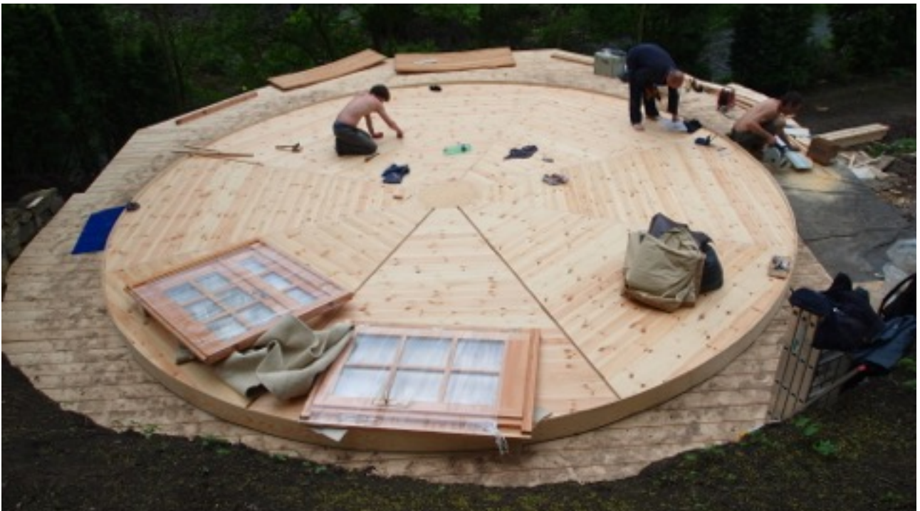
Jurte im Aufbau: zerlegbare, mit Thermohanf isolierte Bodenplatte einer Jurte. Sprossenfenster und Scherengitter liegen bereit zur Montage
