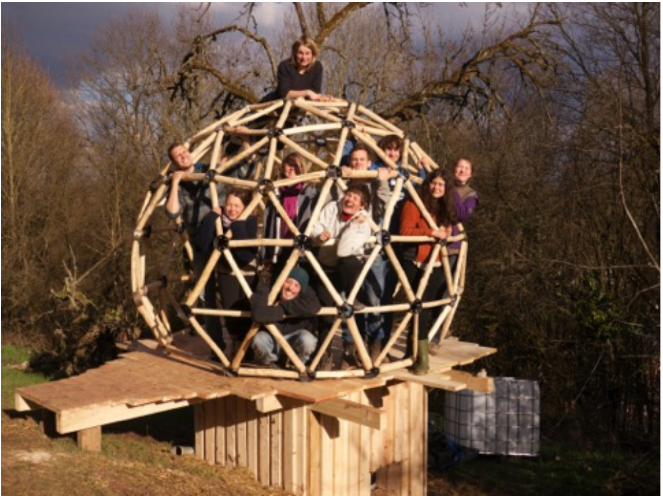
Bau einer Humustoilette mit geodätischer Kuppel. Workshop mit Schülern und Studenten
