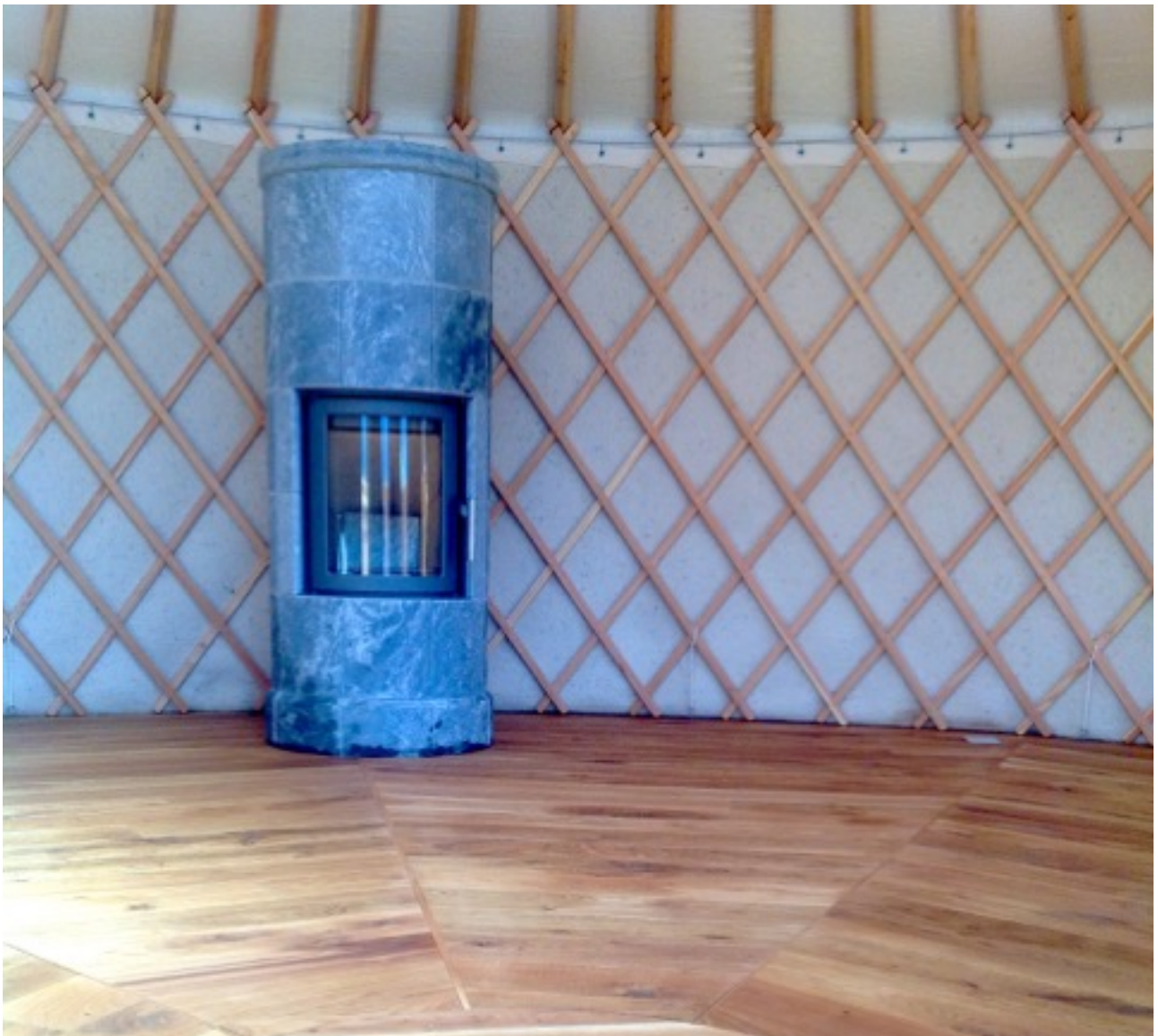
Aufgebaute Jurte. Kaminofen mit Außenluftanschluss und Edelstahlschornstein, Dielenboden in Eiche. Isolation der Wand und der Decke mit Thermohanf und Wollfilz.
